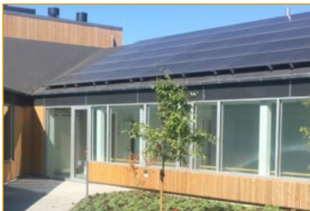
Figur B3 Solceller på Køge Nord Plejecenter, foto fra Dominia ©.
